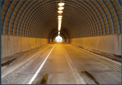
地下空間調査
